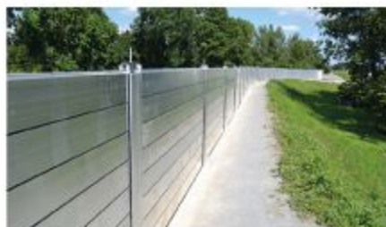
Protipovodňové hrazení, Benátky nad Jizerou
